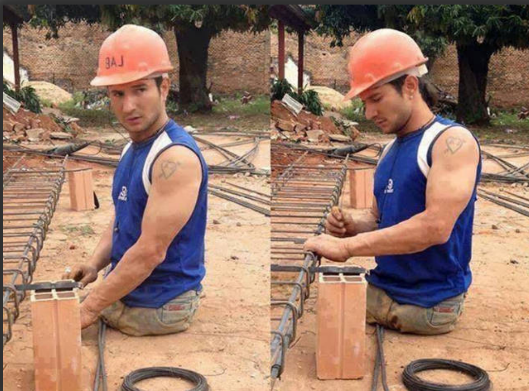
21 – ouvrier maçon cul-de -jatte au travail sur un chantier
