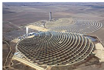
Source d'énergie renouvelable, les tours solaires thermiques utilisent le soleil comme ressource naturelle . Depuis la gauche : les tours solaires PS10 et PS20 en Espagne .
