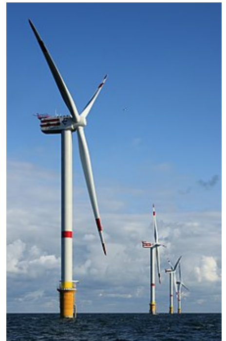
La ressource renouvelable qu'est le vent alimente cette éolienne de 5 MW dans un parc éolien à 28 km au large de la Belgique .
