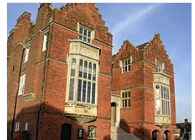
Bâtiment de la public school de Harrow.
